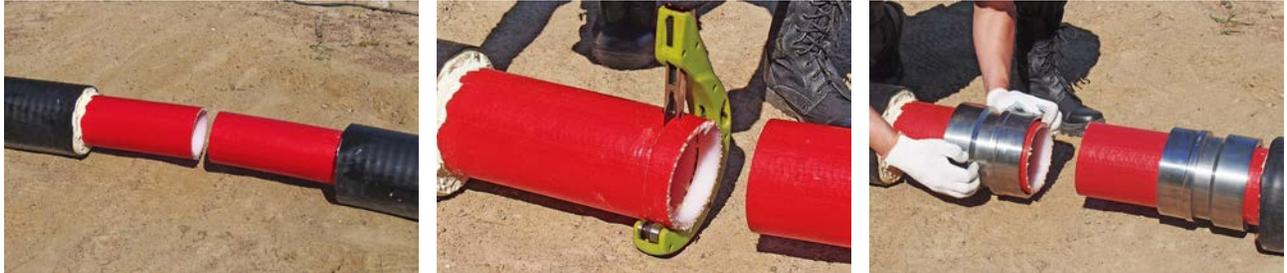
Надеть на рабочие трубы монтажные гильзы фиксирующей проточкой в сторону присоединяемой муфты. Произвести развальцовку трубы ручным или гидравлическим инструментом в два приема, повернув расширительную насадку относительно трубы после первой развальцовки на 30°.
