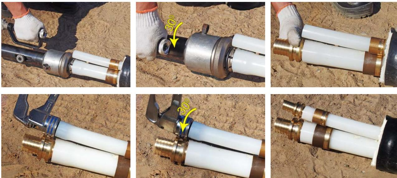
Вставить соединительную муфту в развальцованную трубу. Через небольшой промежуток времени труба плотно обожмёт муфту.
