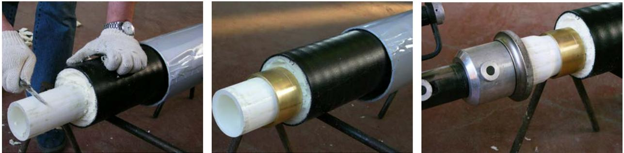
Вставить фитинг в развальцованный конец трубы. Используя насадку с захватами, надвинуть инструментом гильзу на фитинг до упора. Вставить свободный конец фитинга в заранее развальцованный конец присоединяемой трубы и произвести аналогичные действия для нее.
